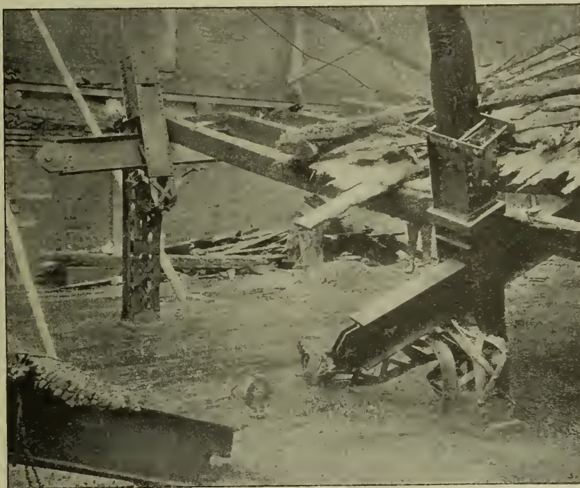
Eiserne Gitterstützen im 4. Boden des Speichers Kehr wieder No. 4 u. 5 in Hamburg. Nach dem Brande vom 11. Juli 1894.
